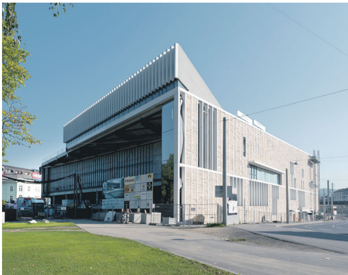
Hitzig diskutiert, zuletzt durch einen Dachbrand lädiert: Fassade des Linzer Opernhauses. Foto: Rauchdobler
